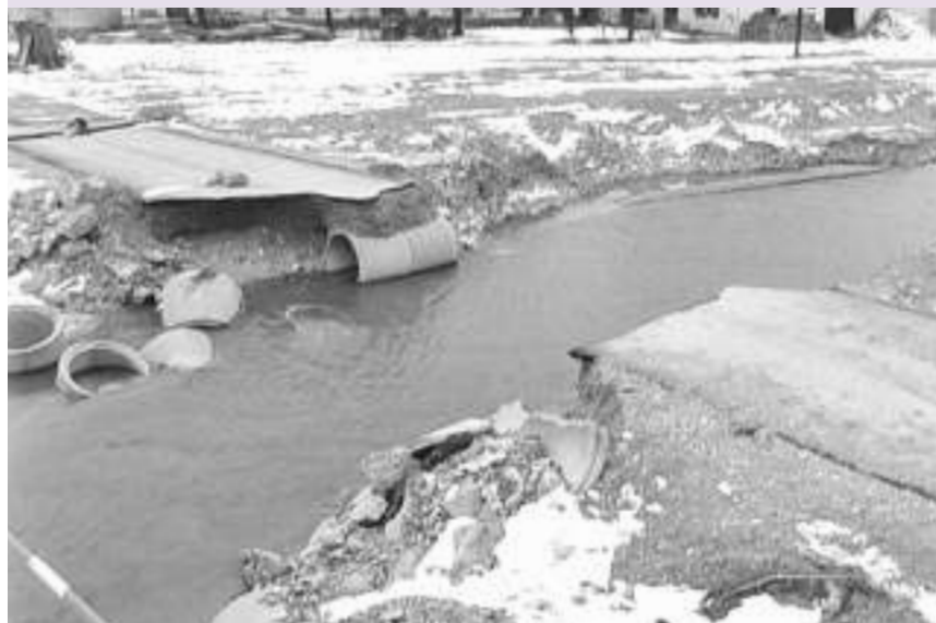
Срушен мост у Великој Каменици
