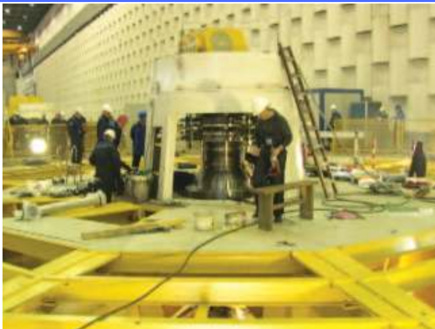
Радови на ревитализацији хидроагрегата
