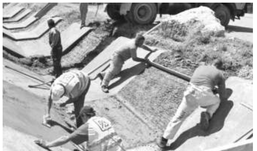
Бетонирање у Подливу
