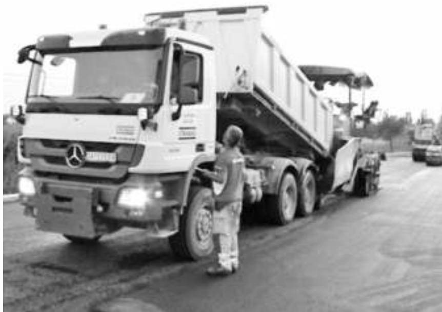
Асфалтирање улице 7.септембар
