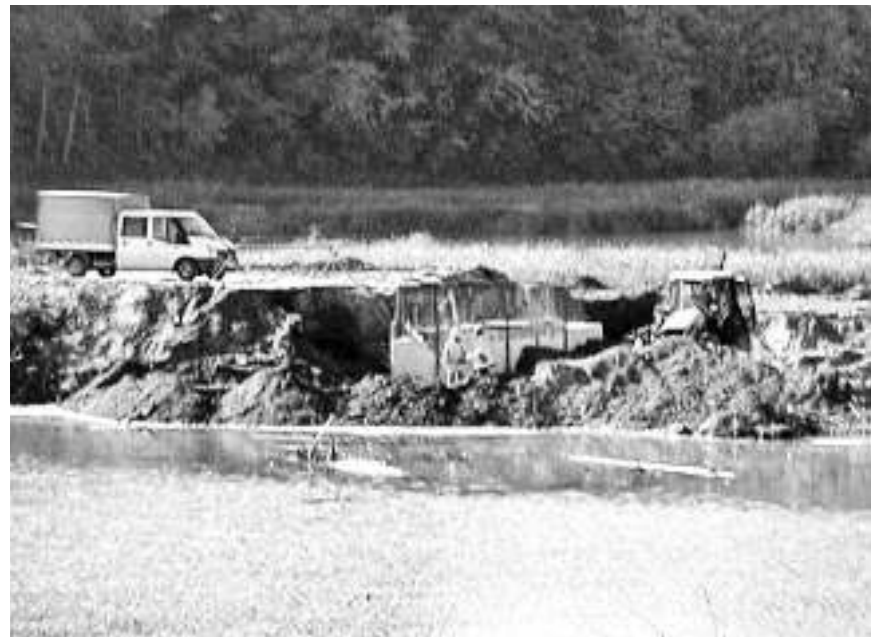
Радови на изградњи моста
