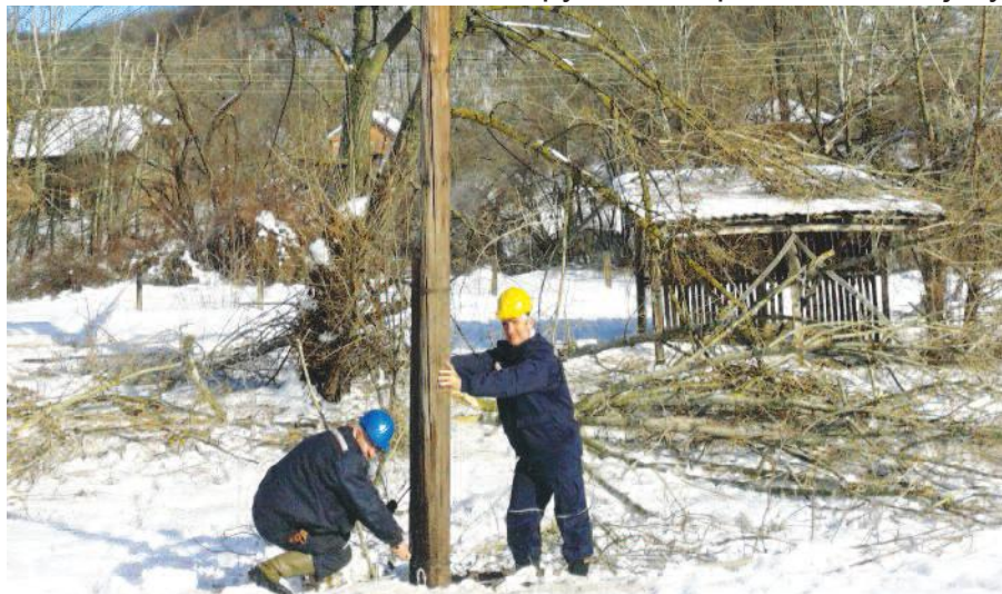
Електромонтери подижу стуб
