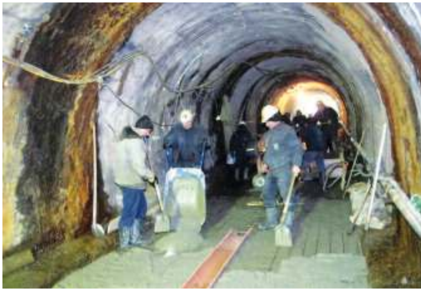
Бетонирање у тунелу
