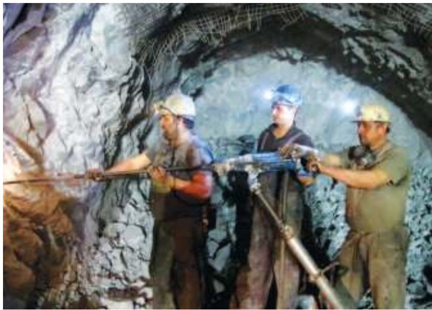
Пробијање ходника којим ће се спојити 17. и 19. хоризонт
