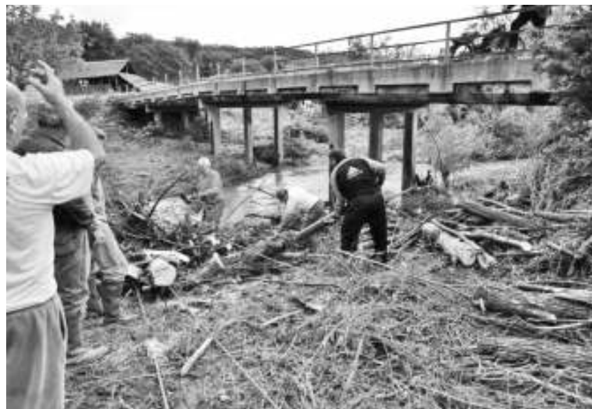
Расчишћавање корита Сиколске реке
